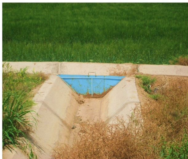
شکل ۴-۵- دریاچه کشویی دوزنقه‌ای، شبکه آبیاری ساوه
