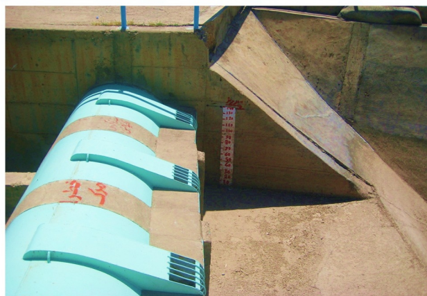
شکل ۴-۶- سرریز سیفونی، شبکه آبیاری ساوه
